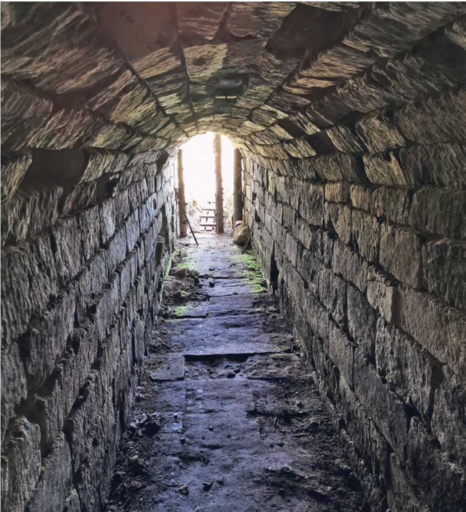
Один из расчищенных сулеренгов – система естественного водонакопления и водоотведения под фундаментом крепостных стен
